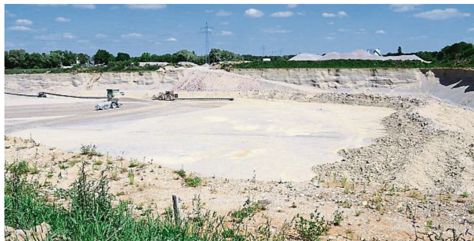
„Wir wollen dem Projekt nicht im Wege stehen“: Für eine Folgenutzung der Kiesgrube im Martinsrieder Feld als Erdbeckenspeicher läuft eine Machbarkeitsstudie der Gemeinde Gräfelung. So lange lässt die Firma Glück die Wiederverfüllung ruhen. FOTO: DAGMAR RUTT
